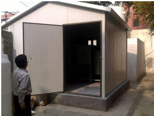
Kleines Haus zur Lösung großer Probleme: Trinkwasseraufbereitungsanlage in Pakistan
